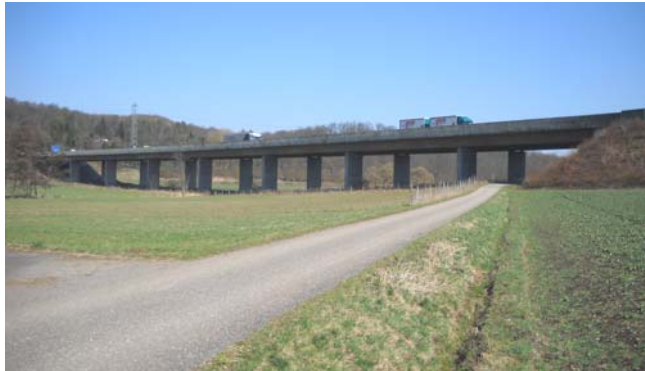
Bild 5: Blick auf die Würmtalbrücke aus westlicher Richtung
